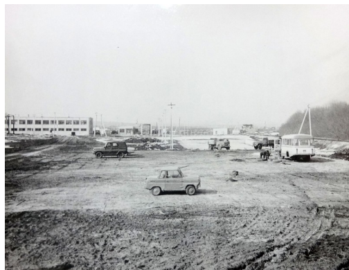
СМЗ-С3Д на будівельному майданчику. Вовчанський агрохімкомплекс, адміністративно-побутовий корпус. 1983 р. [39, Оф-28815, Вст. 53947].
