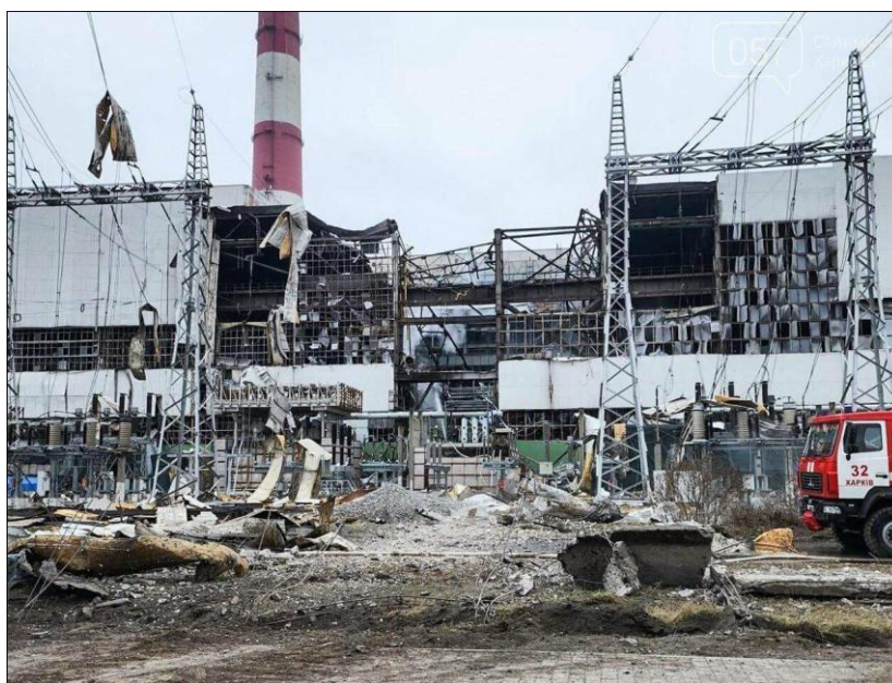
Рис. 3. Зруйнована ТЕЦ-5 внаслідок обстрілу у місті Харків [8] Fig. 3. Destroyed TPS-5 as a result of shelling in the city of Kharkiv [8]
