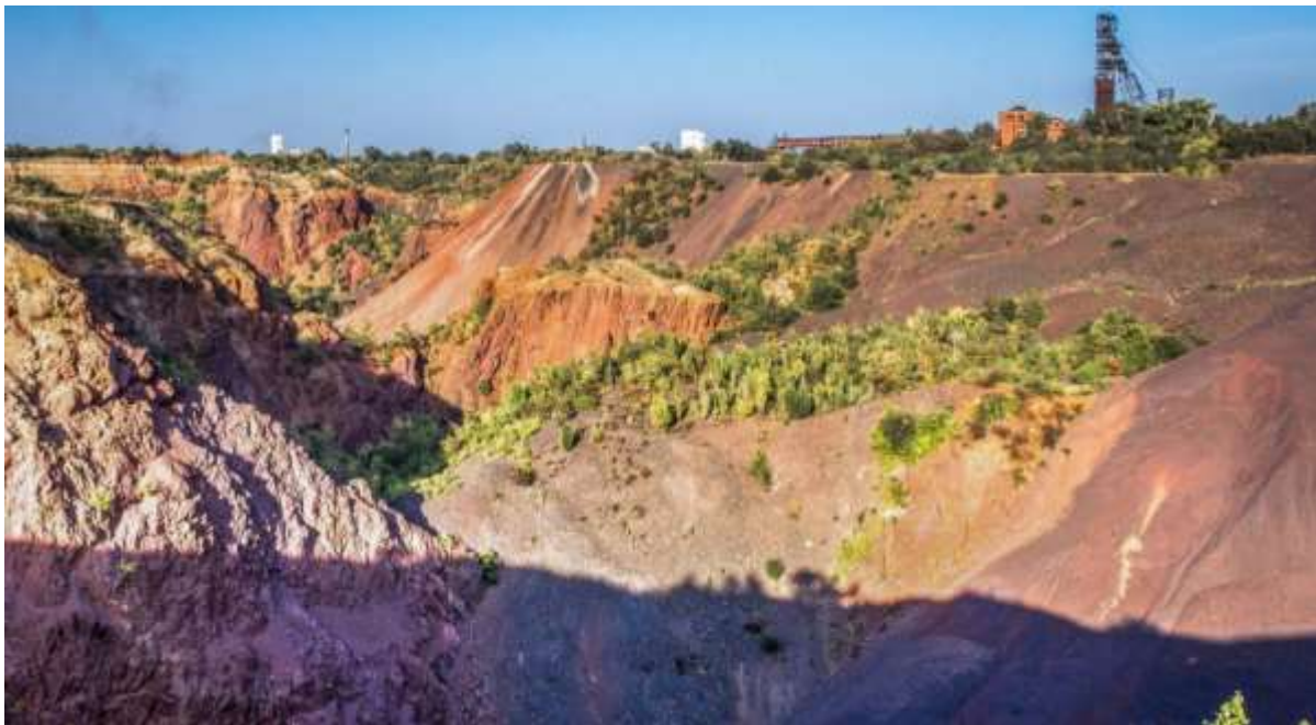
Рис. 6 – Провальна зона залізрудної шахти Козацької Fig. 6 – Collapsed area of the Kozatska iron ore mine
