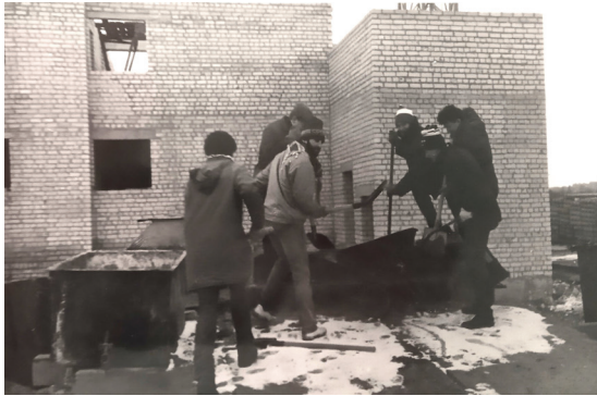
Рис. 4. Співробітники та студенти Харківського державного фармацевтичного інституту на будівництві нових корпусів вишу (фотографія з Музею історії Національного фармацевтичного університету).
