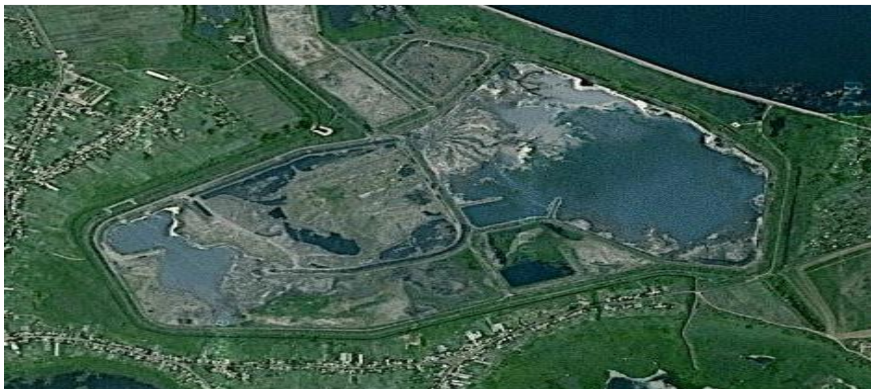
Рис. 4. Общий вид золошлакоотвала Змиевской ТЭС (аэрофотоснимок)
