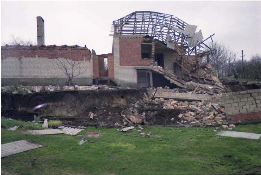
Фото 1. Руйнування нового житлового будинку на зсувному схилі. Фото Дроздова А. В. / Photo 1. Destruction of new residential building on a landslide. Photo by Drozdov A. V.
