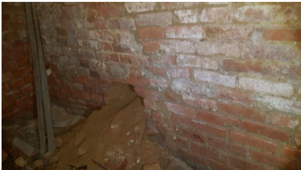
Рис. 8. Точка №2 відбору ґрунту порушеної структури з-за стіни підвалу по осі Б в осях 2-3. Fig. 8. Soil sampling point #2 of the broken structure from behind of the cellar wall at axis B and 2-3
