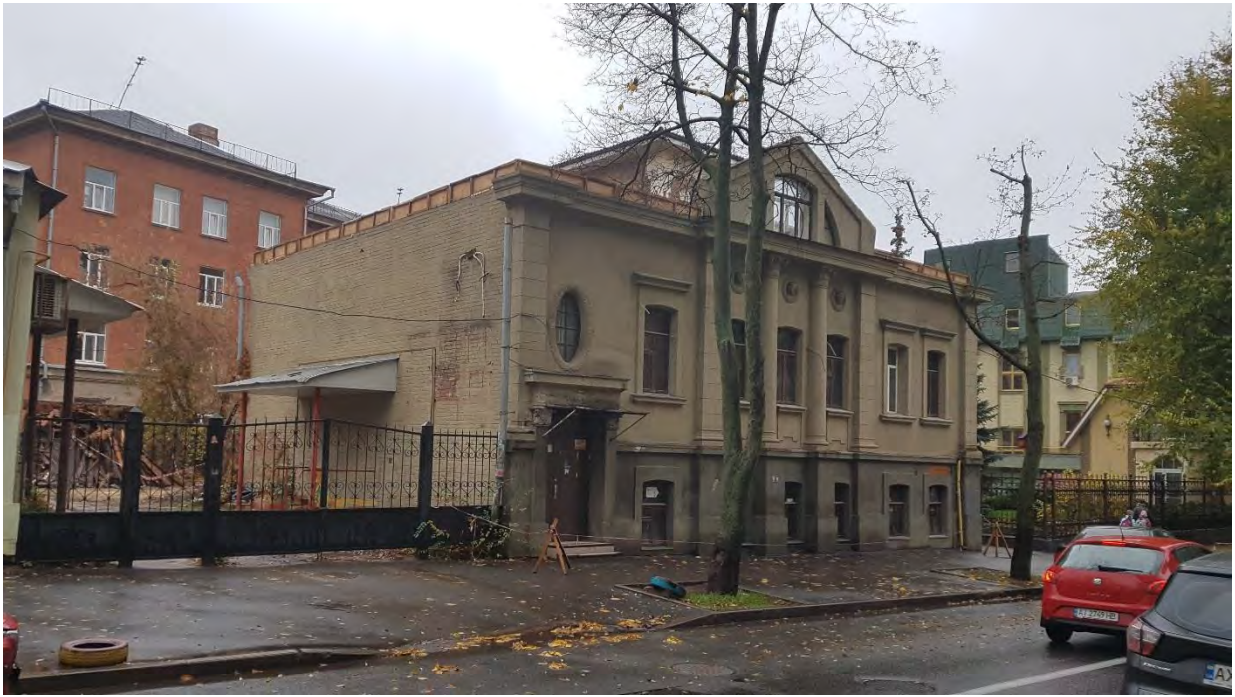
Рис. 4. Загальний вигляд будівлі, головний фасад. Fig. 4. Building overview, main facade
