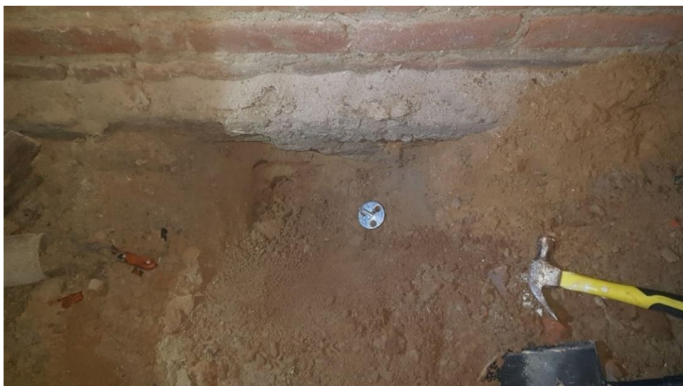
Рис. 7. Точка №1 відбору ґрунту непорушеної структури біля підшови стіни підвалу по осі Б в осях 2-3. Fig. 7. Soil sampling point #1 of the unbroken structure next to the cellar wall at axis B and 2-3
