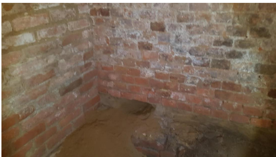
Рис. 9. Точка №3 відбору ґрунту порушеної структури з-за стіни підвалу в місці перетину осей Б та 2. Fig. 9. Soil sampling point #3 of the broken structure from behind of the cellar wall at intersection point of axis B and 2
