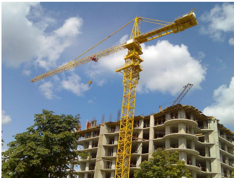
Рис. 1 – Первый отечественный башенный кран нового поколения КБ-471
