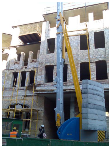
Рис. 8 – Малогабаритный быстромонтируемый башенный кран IGO 36 производства фирмы POTAİN
