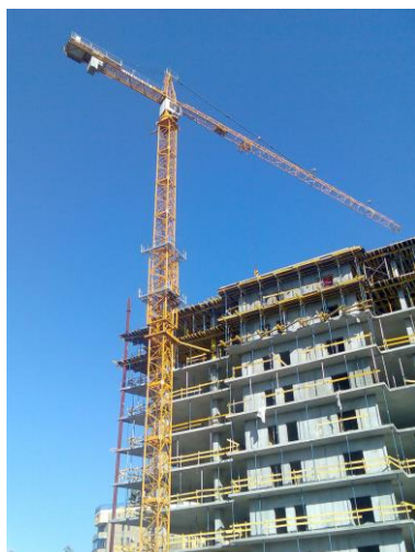
Рис. 3 – Приставной наращиваемый башенный кран фирмы Liebherr
