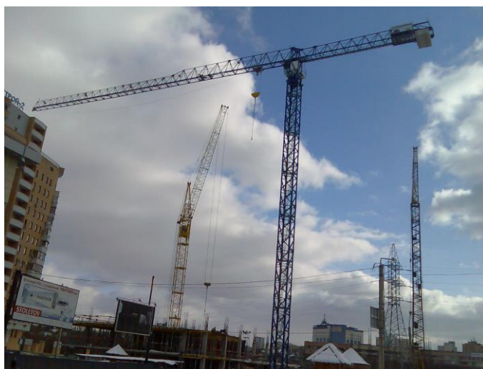
Рис. 5 – Стационарный башенный кран с плоским верхом фирмы Linden-Comansa
