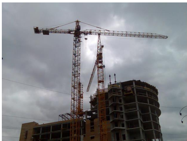
Рис. 6 – Установка двух башенных кранов на одном объекте
