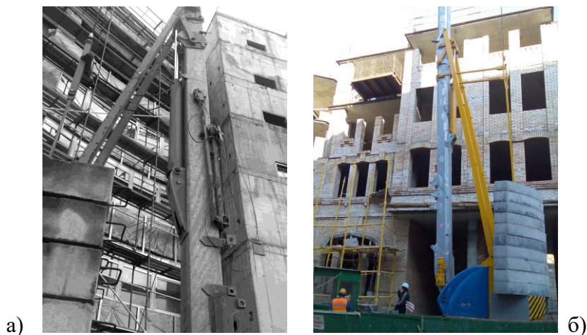
Рис. 7 - Монтажный гидроцилиндр на башне крана: а) EUROGRU 185.8;б) IGO 36
