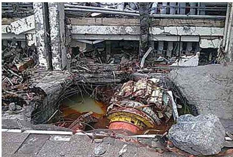
Рис. 6 – ГА-2 после аварии ( http://bigpicture.ru/?p=4962 )
