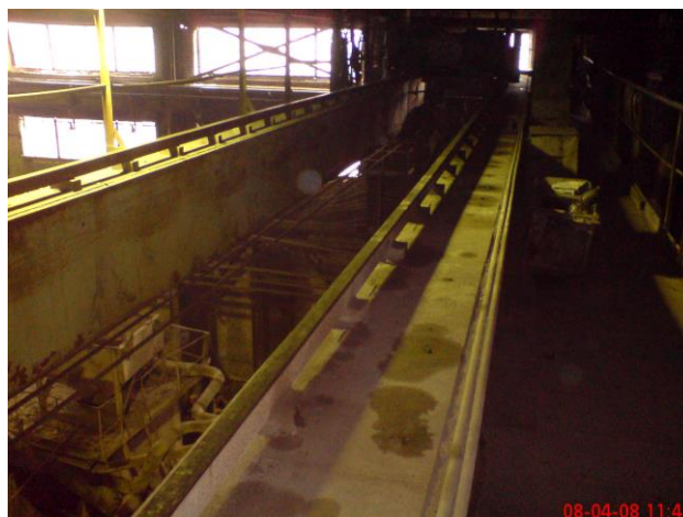
Рис. 4 – Выставка подтележечного рельса на опорные детали
