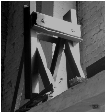
Рис. 4 – Кінцевий упор мостового крана 5т40
