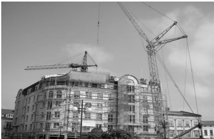
Рис. 2 – Демонтаж «замурованного» башенного крана при строительстве жилого дома, г. Ивано-Франковск, 2006 г.
