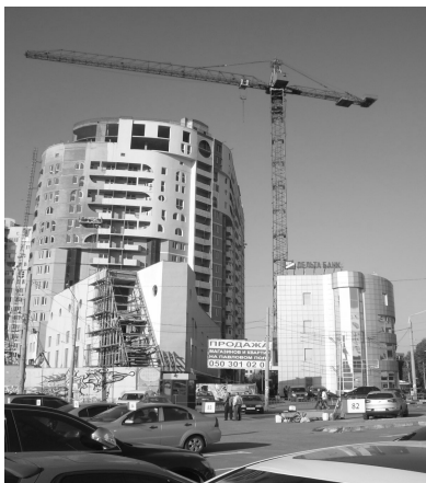
Рис. 7 – Башенный кран КБ-674 на строительстве жилого комплекса
