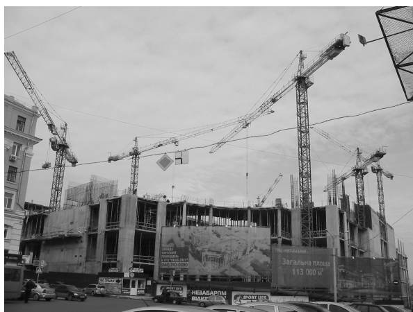
Рис. 3 – Комбинированная установка приставных башенных кранов, г. Харьков, 2015 г.
