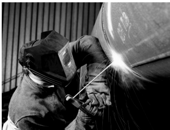
Рис.2. Вигляд процесу зварювання трубопроводу у монтажних умовах
