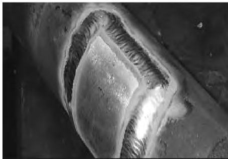
Рис.2 – Зовнішній вигляд зварного з'єднання
