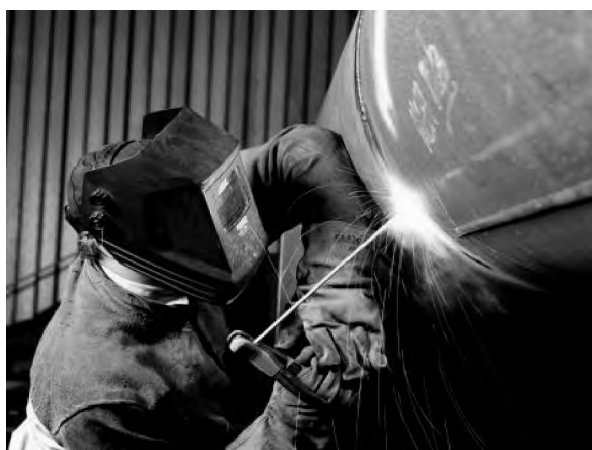
Рис.2. Вигляд процесу зварювання трубопроводу у монтажних умовах
