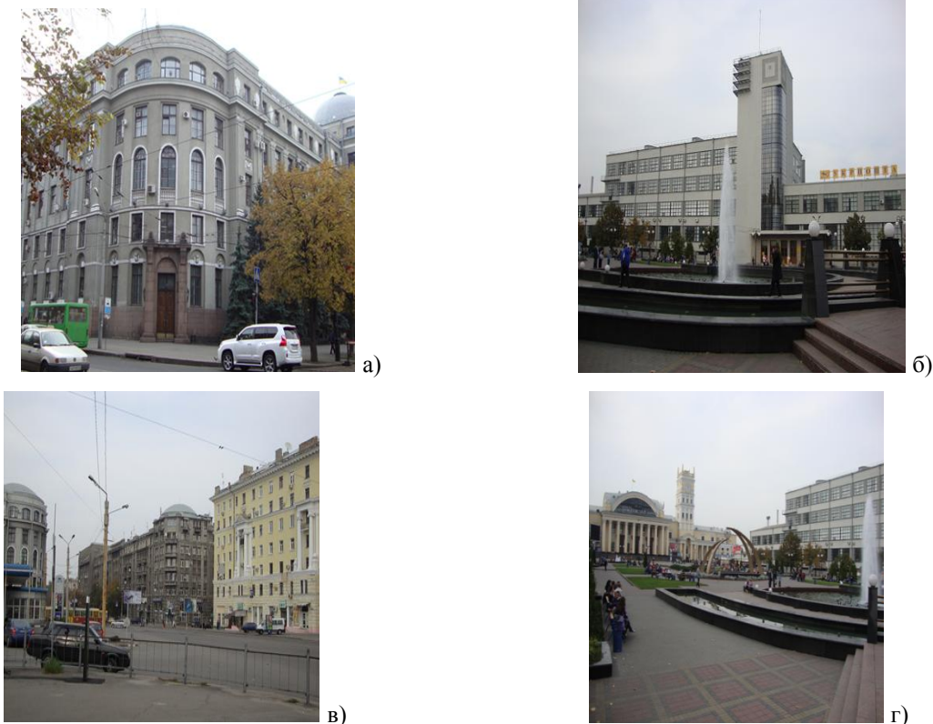
а) управління Південної залізниці; б) будинок Головоштамту; в) житловий будинок для працівників Південної залізної дороги; г) будівля вокзалу
