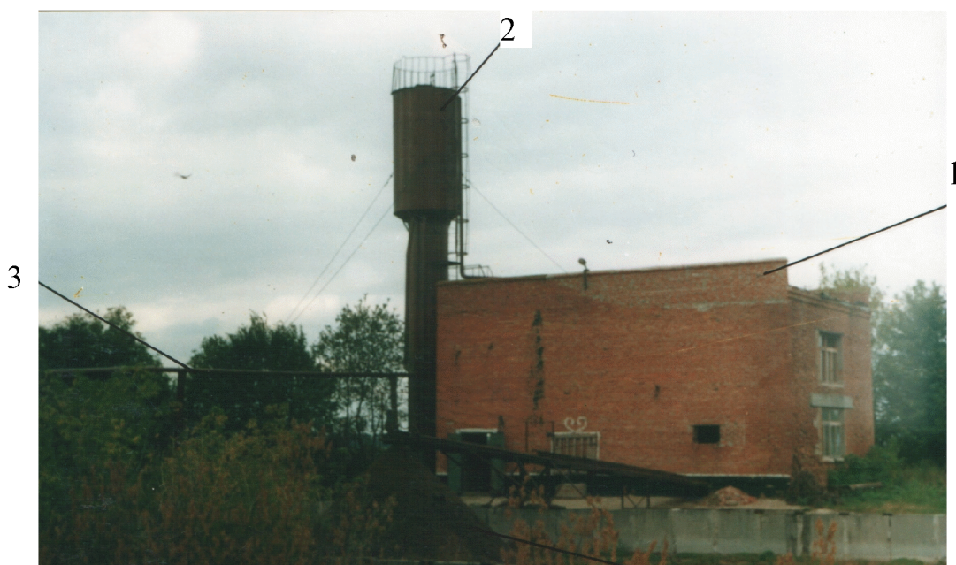
1 - цех розділення стоків; 2 - пристрій розділення стоків; 3 - трубопровід подачі рідкої фракції на карантинування; 4 - тверда фракція.
