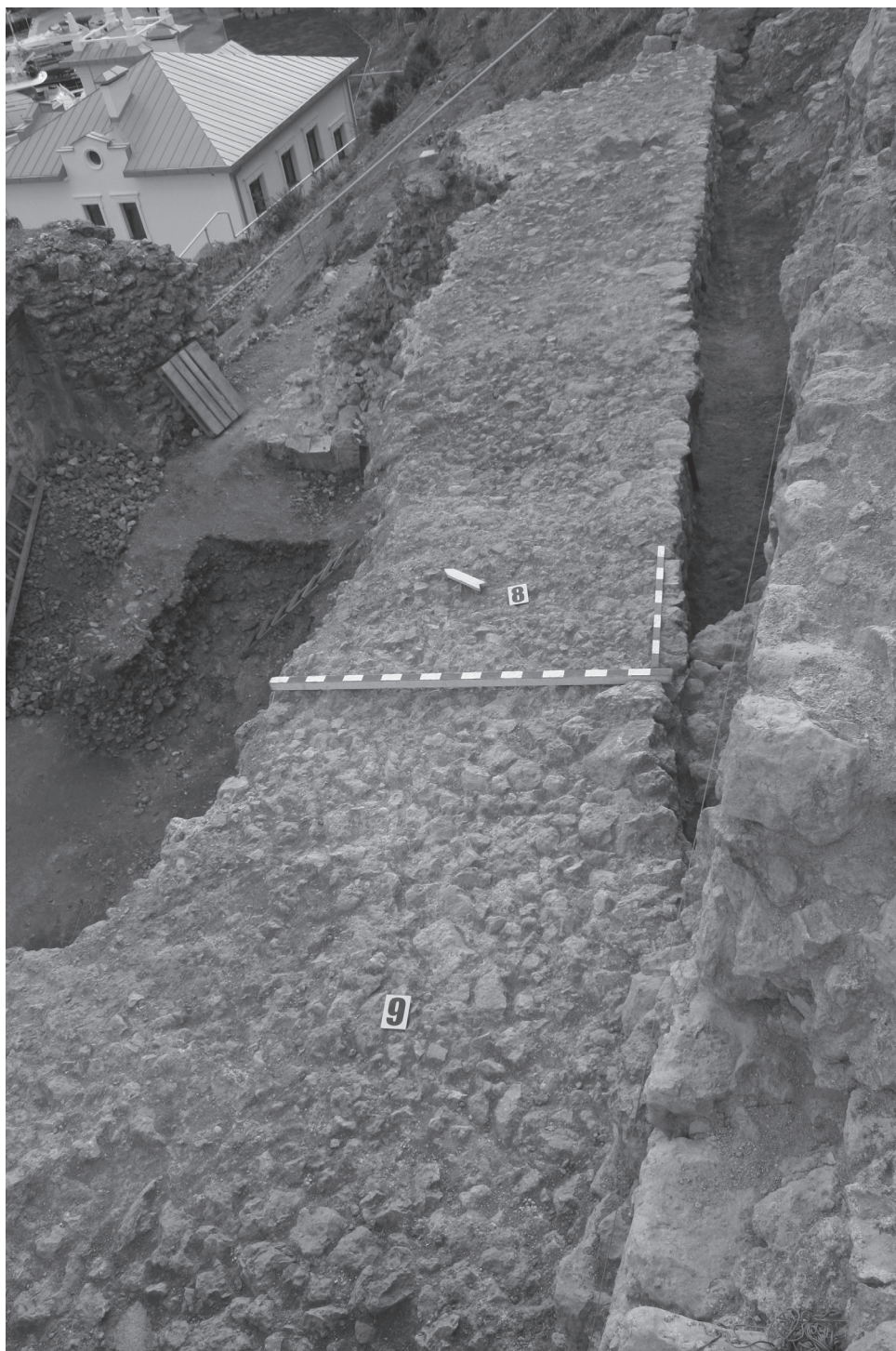
Fig. 9. Fragment of battle ground for setting missile machines. Tower No. 6. Western view Рис. 9. Фрагмент боевой площадки для установки метательных машин. Башня № 6. Вид с запада
